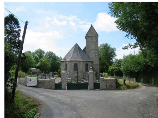
Eglise de Saultchevreuil-du-Tronchet. Vue de la tour-clocher et de l'abside à trois pans coupés © ASVPVS.
