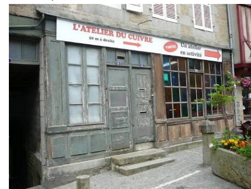
Devantures en applique d'ateliers boutiques avec allèges pleines menuiseries
