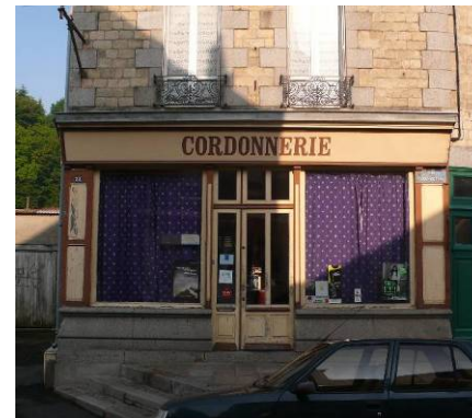
Devantures en applique sur allège en pierre de granite moulurée rapportée
