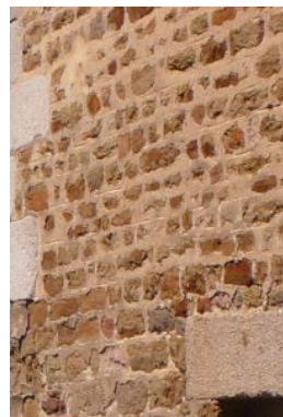
Evolution des parements : du moellon tout-venant au parement de petit appareil homogène.
