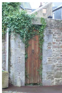
Porte piétonne à planches percées dans murs de clôtures
