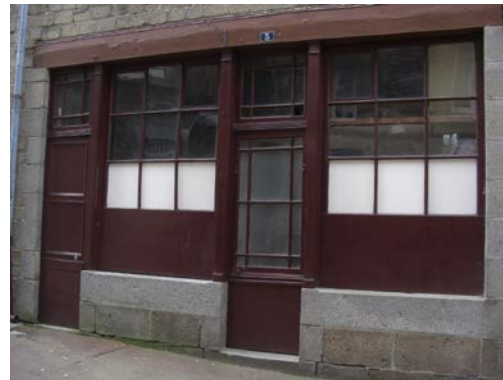
Percements d'ateliers présentant un ensemble menuisé s'apparentant à une devanture en feuillure
