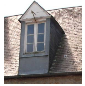
Anciennes lucarnes à engranger transformées ou non en fenêtres de toit à allège pleine
