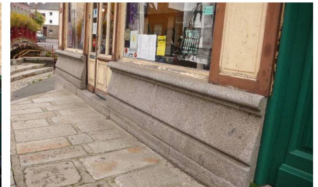
Devantures en applique sur allège en pierre de granite moulurée rapportée
