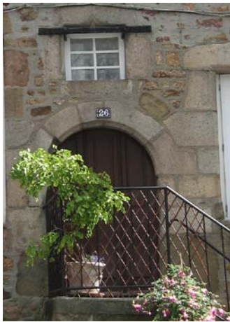
Portes à planches larges et pentures avec ou sans oculi
