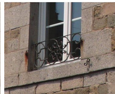
Exemples de barre d'appui en fer forgé
