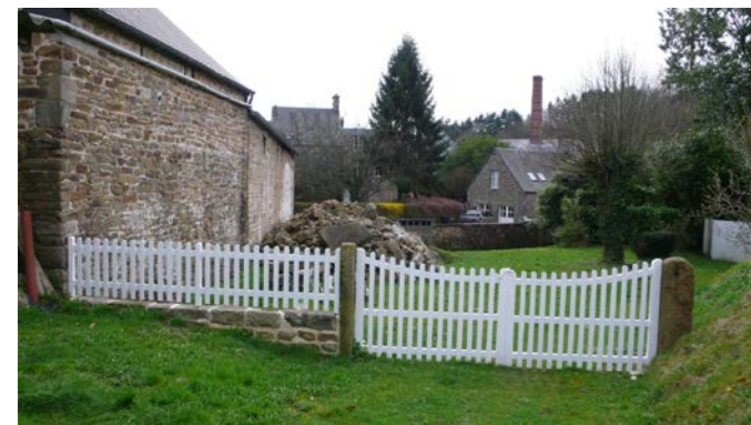
Portails et clôtures en bois à panneaux pleins ou barreaudage droit en bois sur mur bahut.
