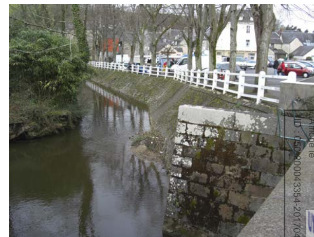
Berges du début du XX e siècle de la place des Costils servant de soutènement au remblai de la place
