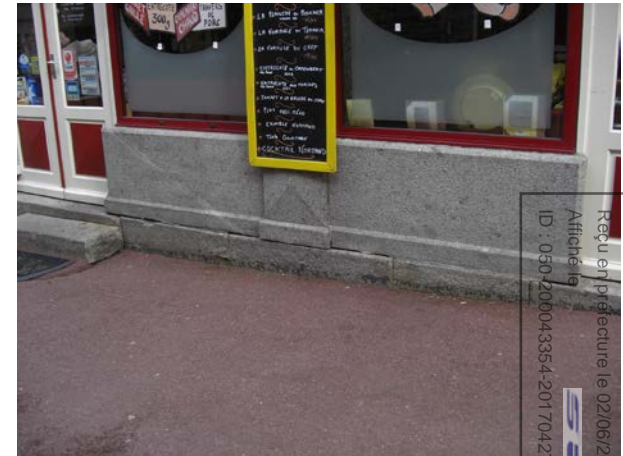
Autres exemples de devantures en applique avec allèges pleines en granite droites ou moulurées
