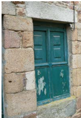
Vestige de menuiserie à traverse et meneau
