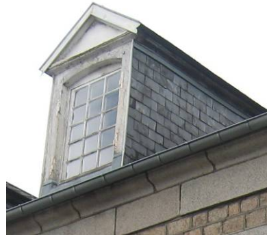
Lucarnes à fronton XVIII e , XIX e sur toit à deux pentes.
