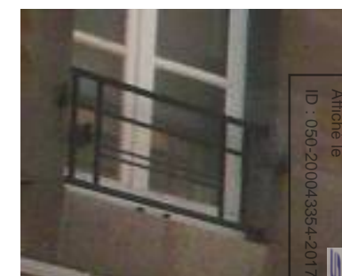
Exemples contemporains à barreaudage droit s'adaptant aux fenêtres anciennes
