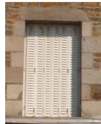
Persiennes métalliques se repliant sur les tableaux
