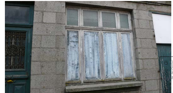
Exemple de menuiserie bois ouvrants, deux fixes latéraux et une imposte fixe divisant une baie large d'atelier en rez-de-chaussée en cohérence avec le rythme des baies de l'étage.
