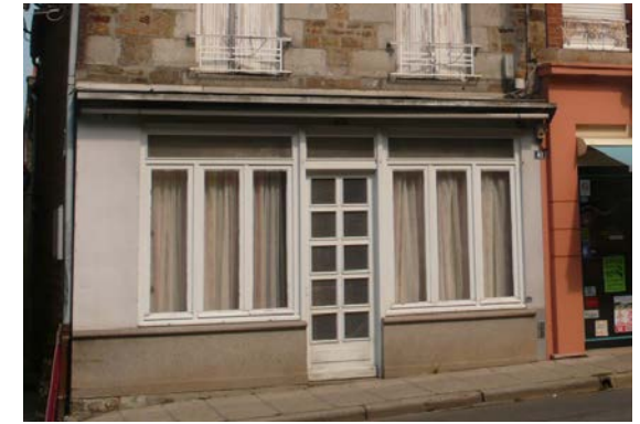
Devantures en applique sur allège maçonnée
