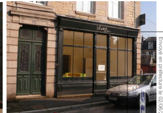
Devantures en applique de boutiques avec allèges pleines menuisées et huisseries fines en bois et métal
