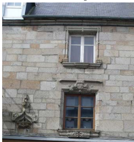
Exemples antérieurs à la période classique de mise en œuvre de pierre de taille de granite en parement
