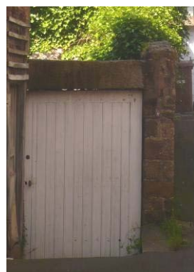
Porte piétonne à planches percées dans murs de clôtures
