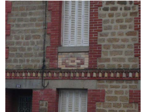
Encadrement et bandeaux alternant briques rouges et émaillées
