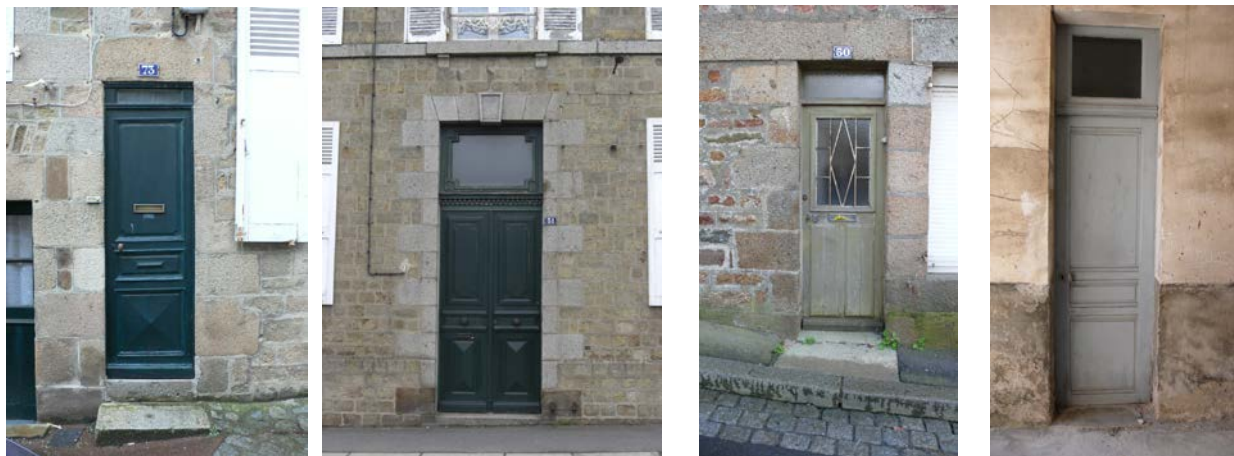
Portes à un vantail à cadre panneaux et moulures surmontées d'une imposte fixe vitrée.
