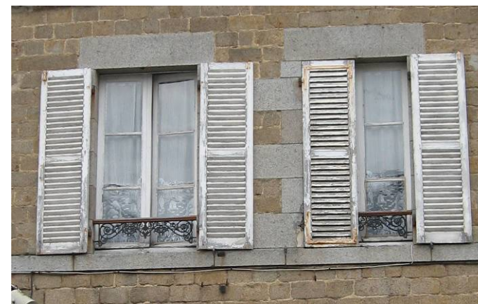
Exemple de baies courantes du XIX e siècle à linteau droit, menuiseries à grands carreaux en bois, garde-corps en fonte et volets persiennés
