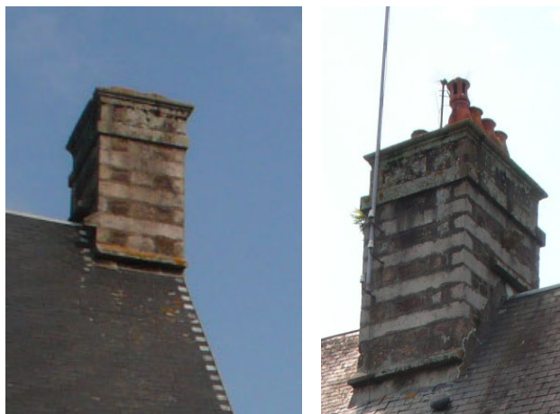
Cheminées en maçonneries chaînée de pierre de taille de granite datant du XVIII e ou du début du XIX e siècle
