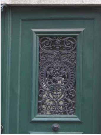
Ouvrages en fonte : garde-corps de balcon et grille de porte d'entrée
