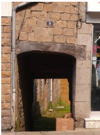
Passage sous bâti couvert, en façade, par un linteau en bois
