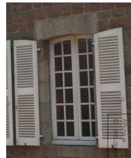
Exemple de baie classique à linteau segmenté, menuiseries en petits bois, garde-corps en fer forgé et volets persiennés en bois
