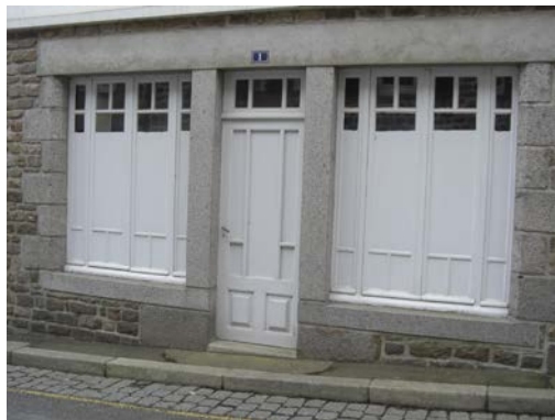
Baies d'ateliers de proportion carrée couvertes par un linteau commun en béton. Ensembles menuisés marquant la verticalité en reprenant le rythme des baies de l'étage.
