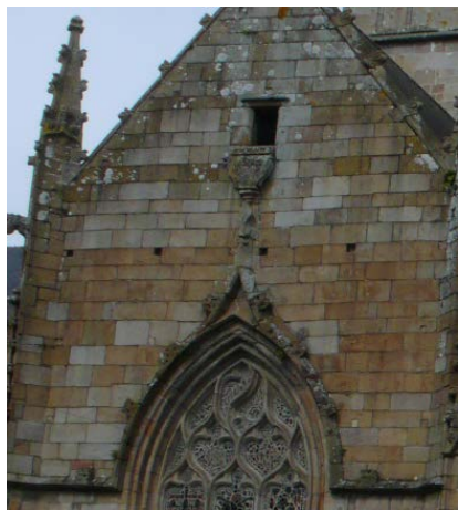
Exemples antérieurs à la période classique de mise en œuvre de pierre de taille de granite en parement
