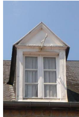
Lucarnes à fronton XVIII e , XIX e sur toit à deux pentes.
