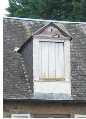
Anciennes lucarnes à engranger transformées ou non en fenêtres de toit à allège pleine
