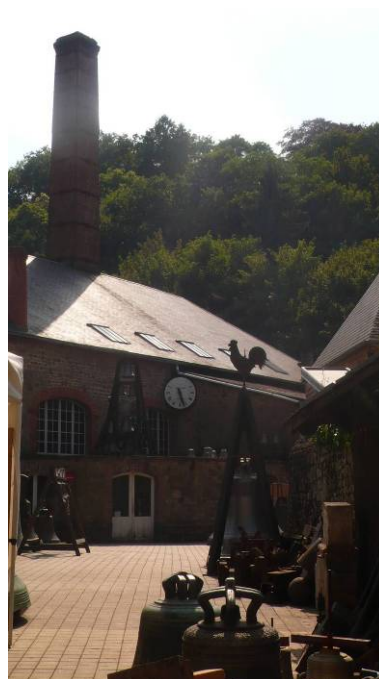
La fonderie Cornillé - Havard
