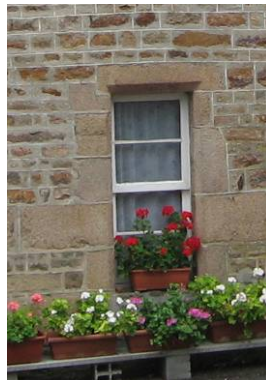
Menuiserie à guillotine dans une baie antérieure au XVIII e
