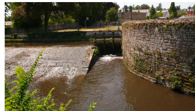
Le barrage en amont du bief de la minoterie
