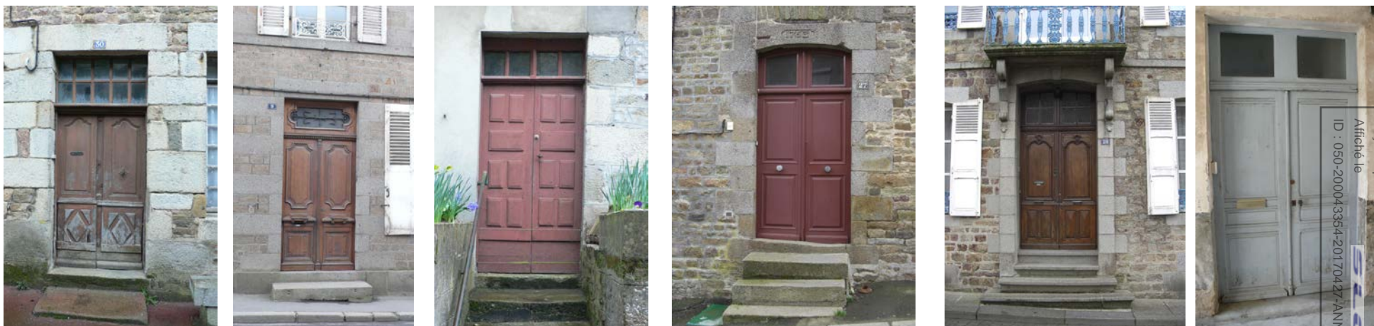
Portes à deux vantaux à cadre, panneaux et moulures surmontées d'une imposte fixe vitrée.
