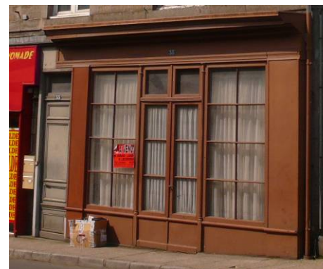
Devantures en applique de boutiques avec allèges pleines menuisées et huisseries fines en bois et métal
