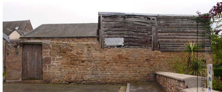
Murs de clôture en pierre avec bâtiments annexes adossés
