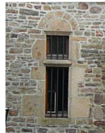
Exemple de baie médiévale à traverse en pierre et barreaudage vertical
