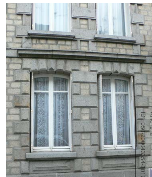
Exemple de baie de la fin du XIX e siècle à linteau mouluré, persiennes métalliques
