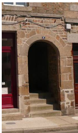
Passage sous bâti couvert, en façade, par un arc plein cintre en pierre
