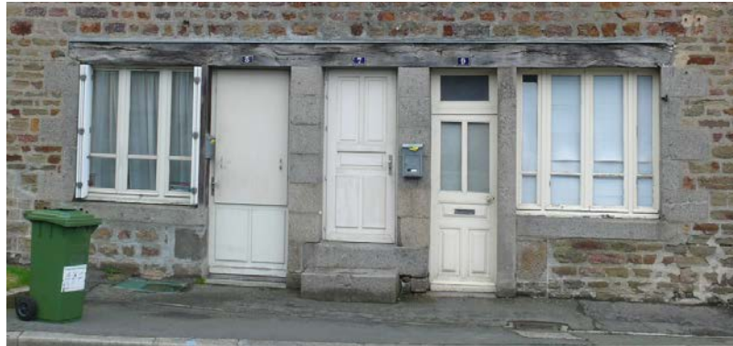
Baies d'ateliers de proportion carrée couvertes par un linteau commun en bois (à gauche menuiserie reprenant le rythme des menuiseries de l'étage à deux ouvrants et un fixe ou deux ouvrants et deux fixes latéraux, à droite, menuiseries neuves en rupture avec le rythme des menuiseries de la façade (deux ouvrants sans parties fixes, trop larges)).
