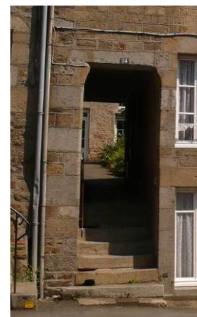
Passage sous bâti couvert, en façade, par un linteau droit en pierre
