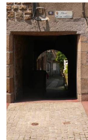
Passage sous bâti couvert, en façade, par un linteau droit en pierre
