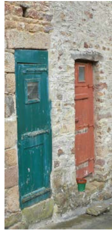
Portes à planches larges et pentures avec ou sans oculi
