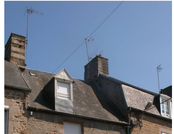
Couverture à deux pans antérieure au XIX e siècle, entre deux toitures réaménagées en Mansart.
