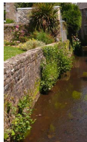
Exemple de berge maçonnée verticalement
