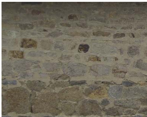
Jointoiment grossier traditionnel recouvrant partiellement les parements de moellons tout-venant
