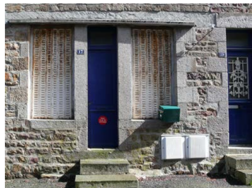
Baies d'ateliers de proportion verticales séparées de la porte d'entrée par un piédroit en pierre de taille de granite
