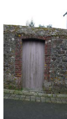
Porte piétonne à planches percées dans murs de clôtures
