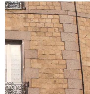
Evolution des parements : du moellon tout-venant au parement de petit appareil homogène.
