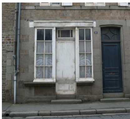
Baies d'ateliers de proportion verticale séparées de la porte d'entrée par un piédroit en bois
