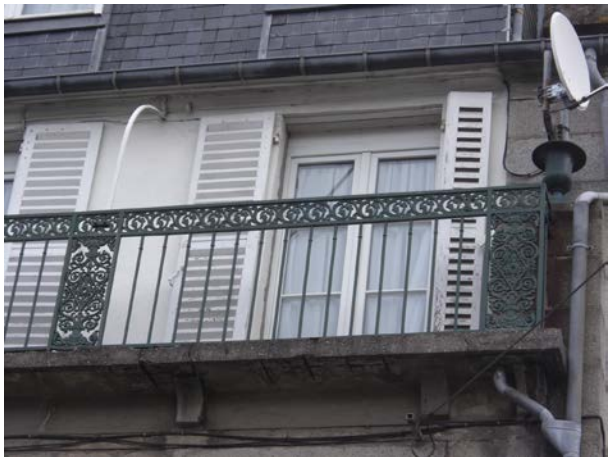
Ouvrages en fonte : garde-corps de balcon et grille de porte d'entrée
