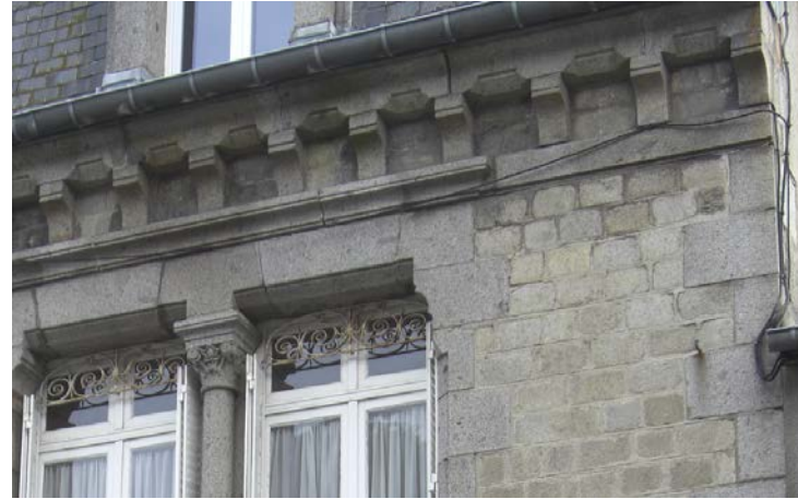
XIX e s. : généralisation de l'emploi du granite gris, mécanisation de la taille, mouluration et sculptures
