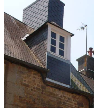
Anciennes lucarnes à engranger transformées ou non en fenêtres de toit à allège pleine
