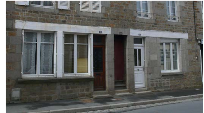
Baies d'ateliers de proportion carrée couvertes par un linteau commun en bois (à gauche menuiserie reprenant le rythme des menuiseries de l'étage à deux ouvrants et un fixe ou deux ouvrants et deux fixes latéraux, à droite, menuiseries neuves en rupture avec le rythme des menuiseries de la façade (deux ouvrants sans parties fixes, trop larges)).
