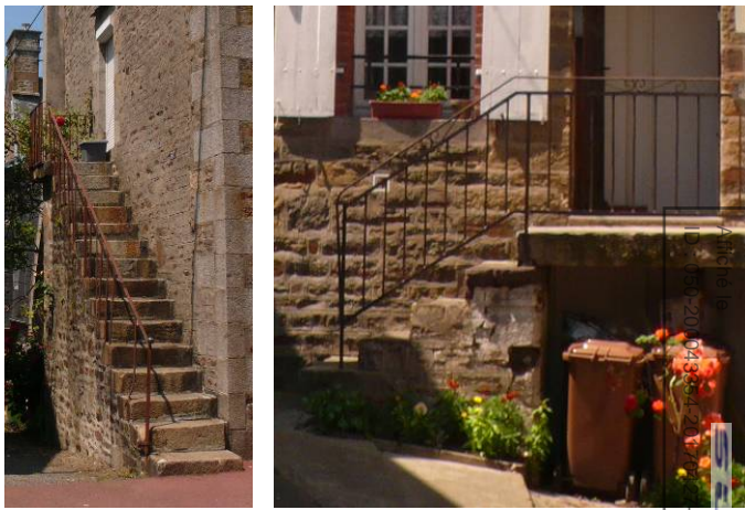
Exemples de garde-corps d'escaliers en fer forgé
