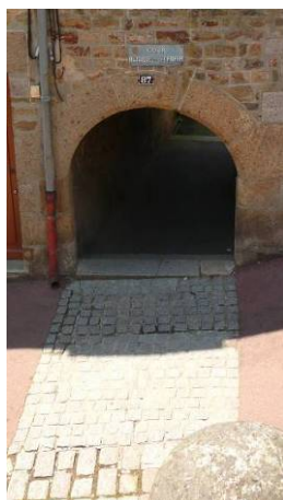
Passage sous bâti couvert, en façade, par un arc plein cintre en pierre
