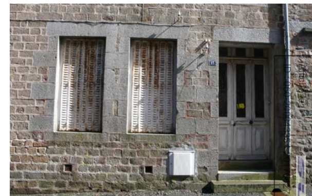
Baies d'ateliers de proportion verticales séparées de la porte d'entrée par un piédroit en pierre de taille de granite
