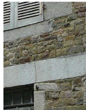
Evolution des parements : du moellon tout-venant au parement de petit appareil homogène.
