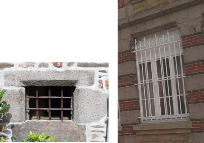
Exemples de barreaudage en fer forgé sur ouverture renaissance et XIX e
