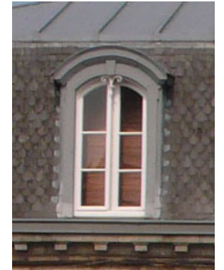
Lucarnes sur toit à la Mansart : à fronton surbaissé et cintré couvertes en zinc
