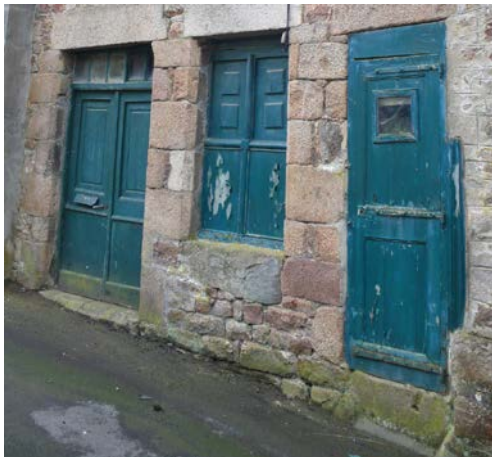
Encadrement et piédroits antérieurs au XVIII e s. en granite roux
