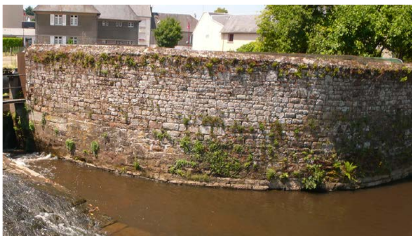
La berge d'origine médiévale au droit du barrage d'édile
