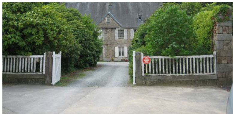
Portails et clôtures en bois à panneaux pleins ou barreaudage droit en bois sur mur bahut.
