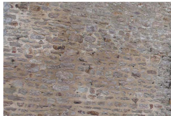
Jointoiment grossier traditionnel recouvrant partiellement les parements de moellons tout-venant
