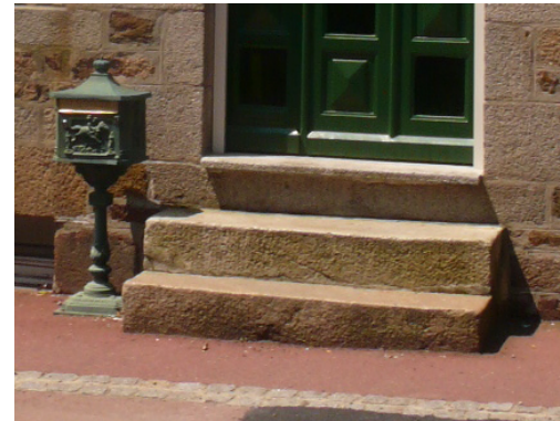
Seuil et perron devant les portes des rez-de-chaussée
